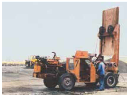
La prima macchina messa a punto da Reinhard Wirtgen era destinata alla frantumazione del cemento armato
